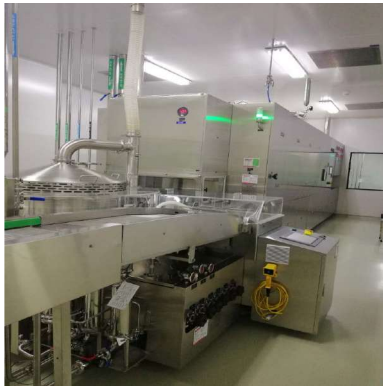
小瓶清洗机和隧道式烤炉
