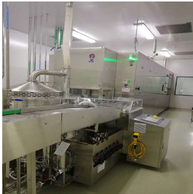
小瓶清洗机和隧道式烤炉
